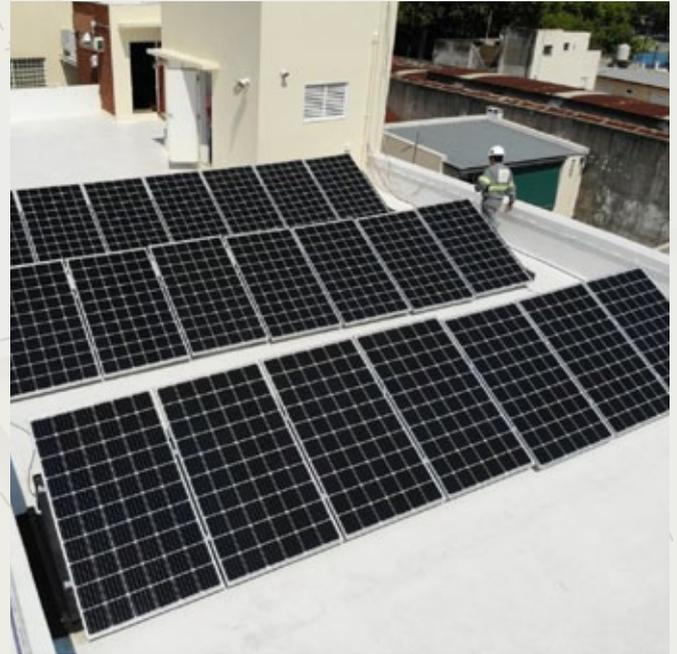
La línea de **Kits Full** es del tipo **híbrida**, es decir que trabaja como un sistema **on-grid** y **off-grid** a la vez. La energía que se genera es usada para el **autoconsumo**, y el excedente no solo se puede **inyectar** a la red eléctrica, sino que también se carga un banco de baterías para tener un **back up** cuando la distribuidora corta el suministro eléctrico.
